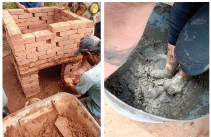
Construção do forno e o preparo da argila
