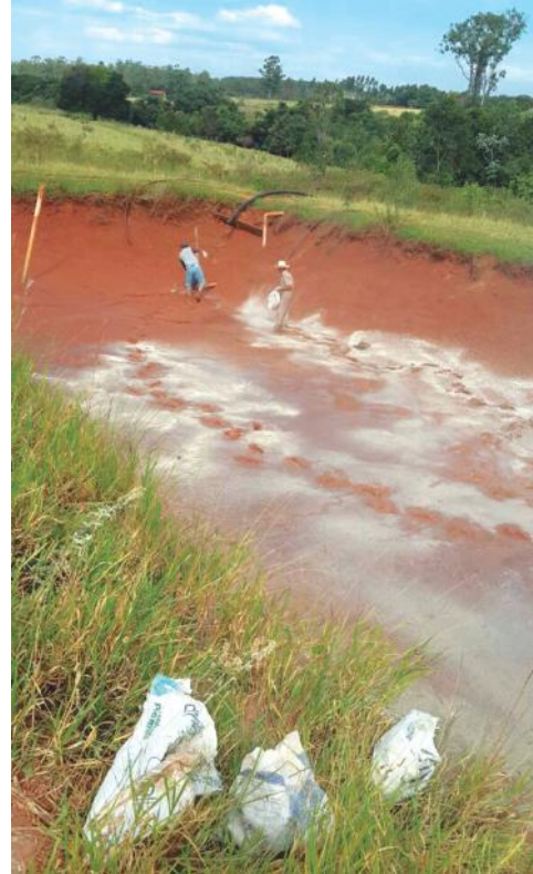
Após esvaziar o tanque, correção dos padrões para obter qualidade da água necessária a receber os alevinos
