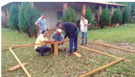
Começando a construção do viveiro
