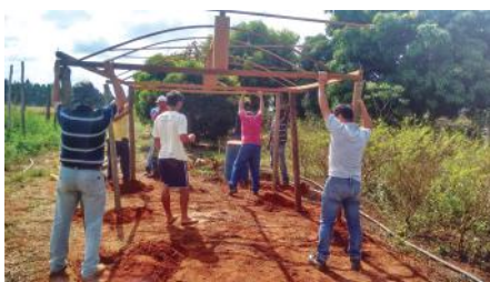
A cobertura é deitada sobre os morrões
