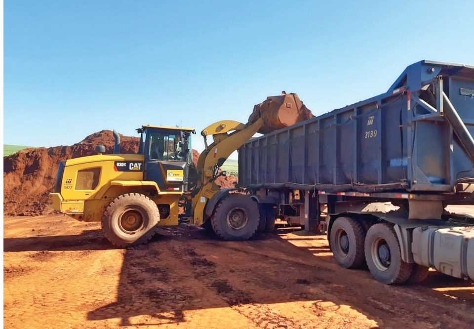
A forma como o operador deve retirar a terra e colocá-la no caminhão
