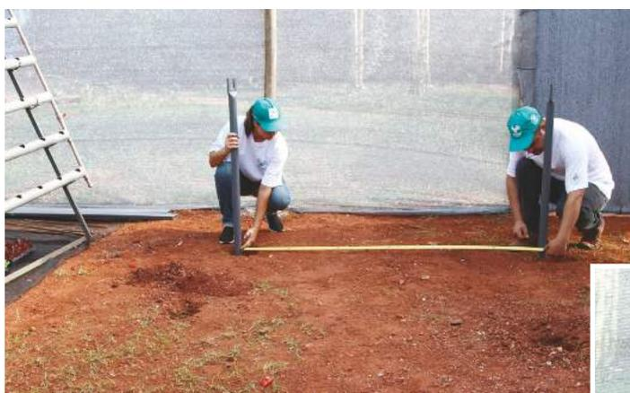
Após o esquadreamento do espaço para montagem do sistema, abrem-se os buracos para instalação dos pés da bancada
